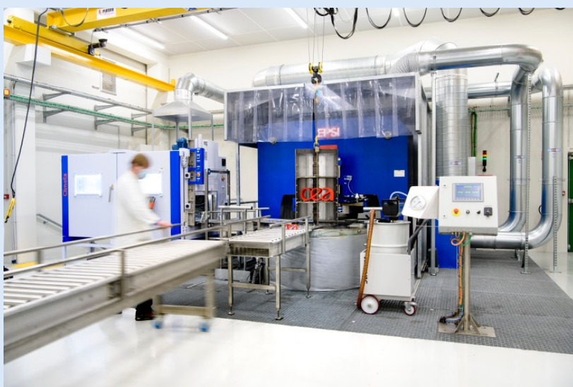
Installation de pressage isostatique de poudre d'explosifs
